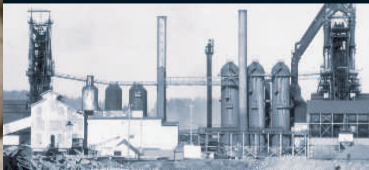
▲ Industria de Aceros Huachipato.
