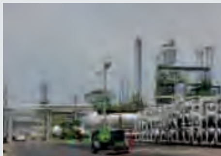
■ ENAP, Planta Refinería Aconcagua.
