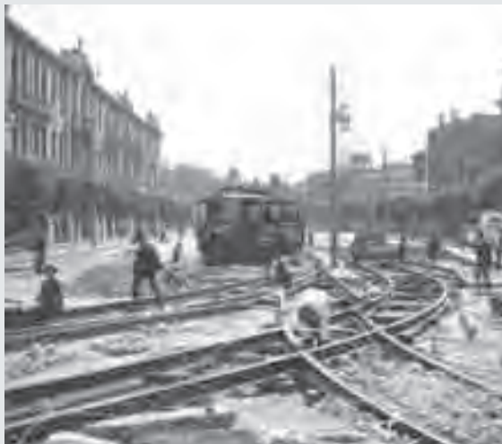
■ Alameda desde Plaza Italia al poniente. Trabajos de adecuación de las líneas del tranvía eléctrico, diciembre 12 de 1927. Fuente: Archivo fotográfico Chilectra, obra citada.
