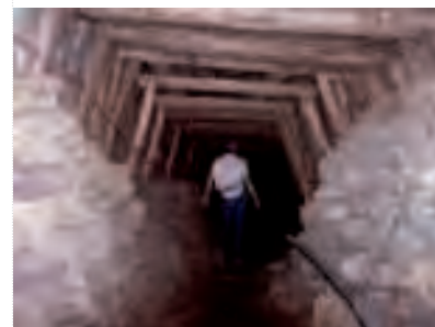
■ Chiflón del diablo, galería del mineral que se interna aproximadamente 1200 metros bajo el Océano Pacífico.
