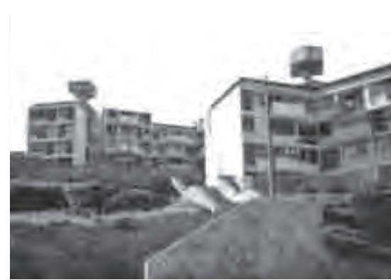
Conjunto habitacional José Ignacio Zenteno, Cerro Barón, Valparaíso, construido en 1963.
