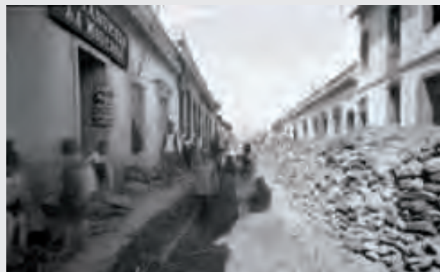
■ Trabajadores encargados de la instalación de líneas subterráneas de electricidad, 1929.
