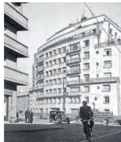
▲ Edificio ubicado en Merced con Santa Lucía. Santiago, 1936.
